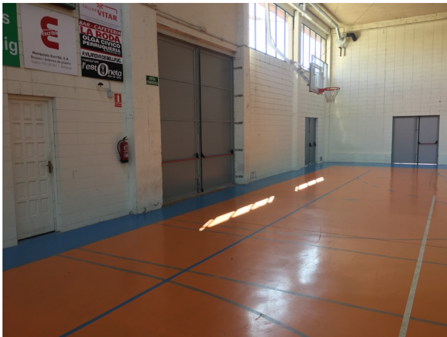
Vista diferents portes (S'observa parament d'obra)
