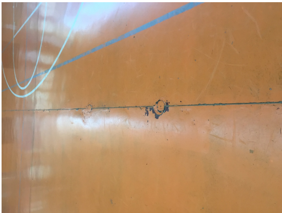
Vista anclatges existents
